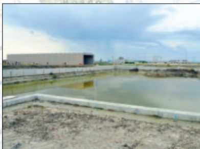
Comune di San Giorgio di Nogaro (Ud), Cranchi SpA : Realizzazione nuova darsena Cranchi-Nausika
