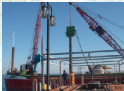
Comune di Lignano Sabbiadoro (Ud), Lignano Pineta SpA : Sistemazione Pagoda
